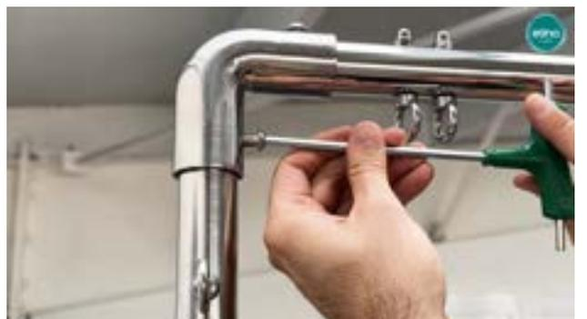
Nous insérons les longues barres dans les structures métalliques que nous avons cerclées, puis nous plaçons et vissons la structure métallique supérieure qui sert de pont.
