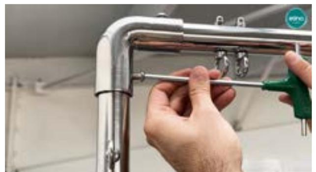
Insertamos la barras largas en las estructuras metálicas que hemos atornillado y a continuación, colocamos y atornillamos la estructura metálica superior que hace de puente.
